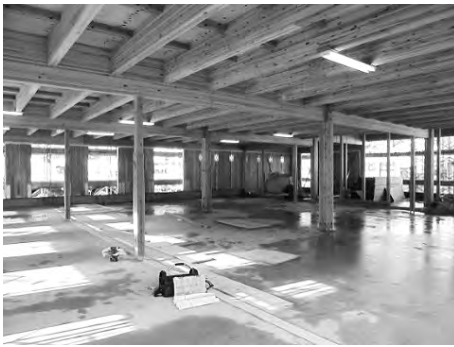
木造での大空間を実現!広々とした内部執務室 1,2階通しのCLTパネルと接合金物
