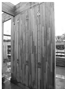
木造での大空間を実現!広々とした内部執務室 1,2階通しのCLTパネルと接合金物
