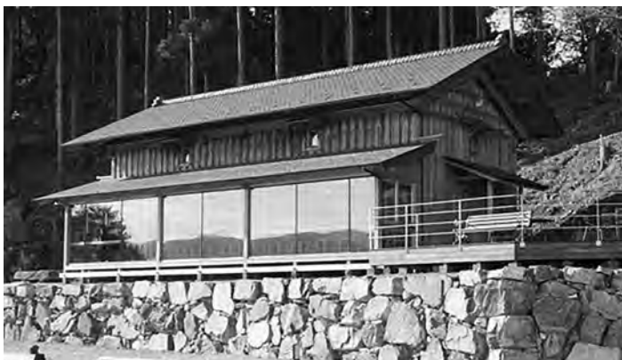
写真3 七間倉。展望カフェとして用いるため、旧下屋にはガラスを入れました。
