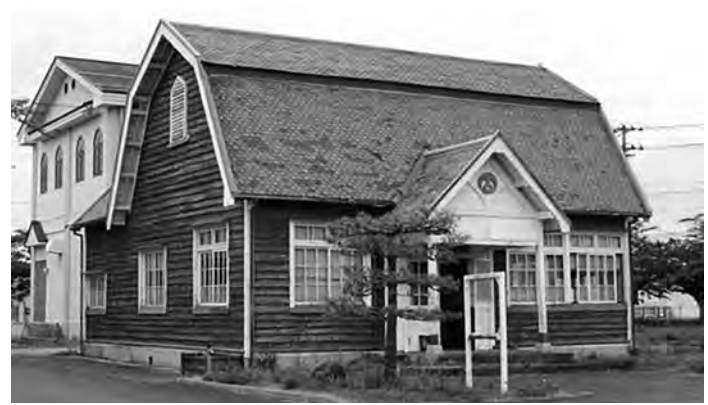
写真4 旧大街道浄水場事務所。解体が済み、長面浦での組立て工事が進行中
